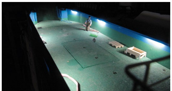
Die Decksbeleuchtung sitzt im U-Profil der Bordwand
